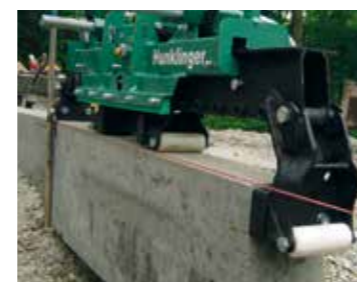
An Schnur anlegen Längsgreifen erlaubt genaues Setzen
